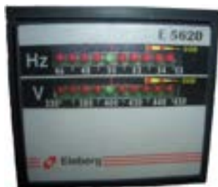
Voltmetro e frequenzimetro led: indicano la tensione e frequenza del gruppo elettrogeno
